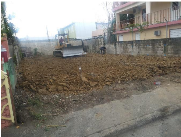
Foto 1- Deposito de relleno
