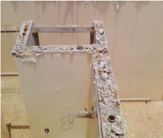
**Foto 2. Paredes de bloque sin anclajes de conexión para la losa de techo. Residencia explorada en la Urbanización Toa Alta Heights, Toa Alta, Puerto Rico**
