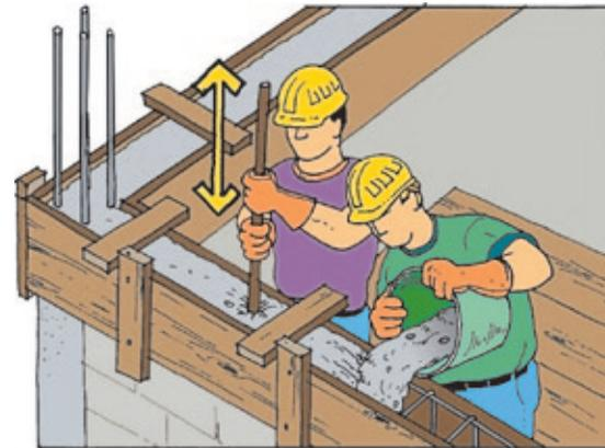
El hormigón de las vigas y columnas debe mantenerse húmedo y protegido del sol y el viento al menos durante los primeros 7 días después de vaciado. El curado del hormigón es fundamental para garantizar la buena calidad y resistencia del material a largo plazo.
