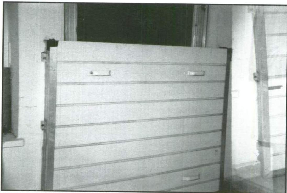
*Figura 74: Compuerta de madera instalada.*
