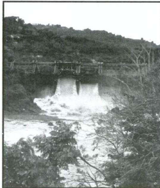
Figura 28: Vista de dos compuertas abiertas de la Represa Carraizo.
