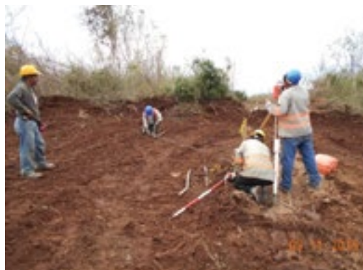
Figura 6. Ejecución de la localización y trazo de estructura [2] .
