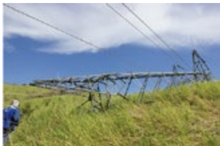
Figura 4. Identificación puntual de los daños a las estructuras de transmisión [2] .
