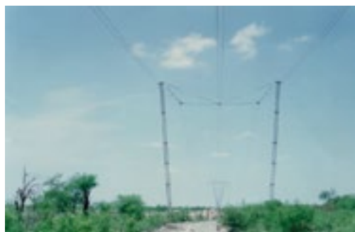
Figura 3. Línea energizada con estructuras de emergencia [1] .
