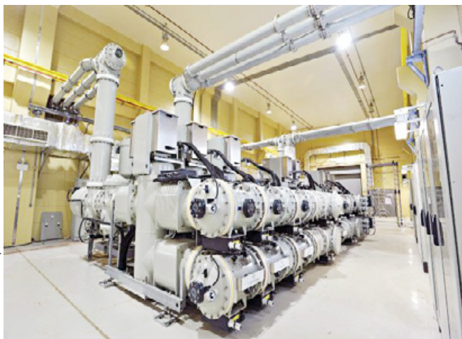
Fig.1 b Una subestación con tecnología aislada por gas (Gas Insulated Substation)."
